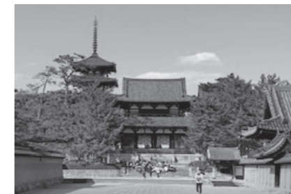
法隆寺西院伽藍(中門と五重塔)
